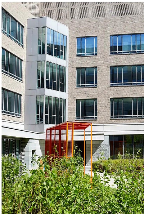
Bâtiment livré · La Plaine Saint-Denis (93) · 2012
